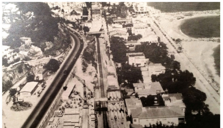
Foto: el viaducte en construcció (anys 60)
